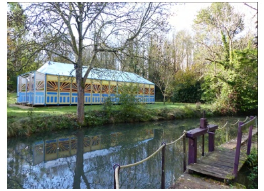
« Bal parquet » du Moulin de Villeneuve
